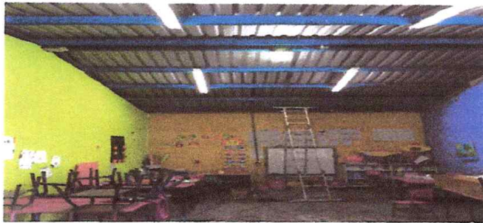
Foto 3: Cambio completo en toda la iluminación en las aulas de la Escuela
