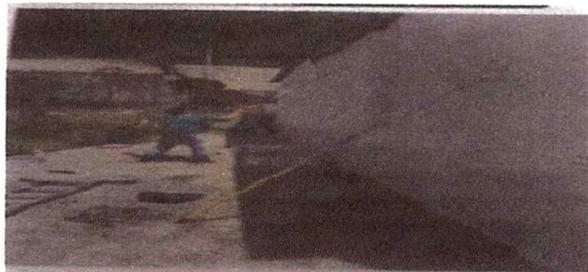
Foto 1: Aplicación de Impermeabilizante en las paredes exteriores de la escuela
