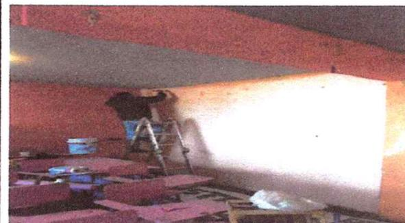
Foto 2: aplicación de Dry-coat Surface Cleaner. Para limpiar las paredes y eliminar el hongo, moho y bacterias en las aulas que lo necesitaban
