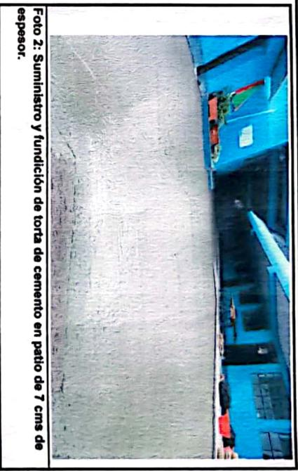
Foto 2: Suministro y fundición de torta de cemento en patio de 7 cms de espesor.
