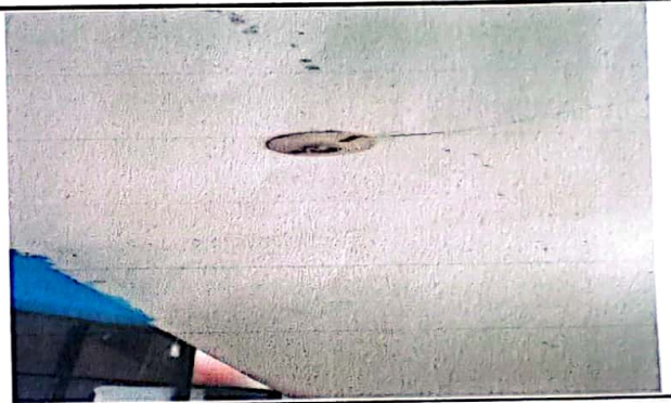
Foto 4: Suministro y Colocación de Luces Led en corredor
