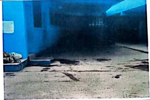
Foto 2: Suministro y fundición de torta de cemento en patio de 7 cms de espesor.
