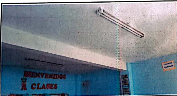
Foto 5: Suministro y Colocación de Luces Led dentro del aula
