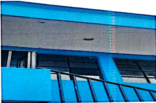
Foto 3: Suministro y Colocación de Luces Led en corredor
