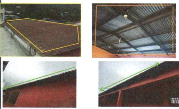
Sustitución y colocación de lamina troquelada calibre 26, Sustitución y colocación de soporte material troquelada, Instalación y colocación de canal plubial pvc abierto, Instalación y colocación de canal pvc cerrado.
