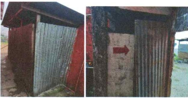
Mantenimiento y colocación de block tabique incluye repeyo, colocación sanitarios aldosa blanco, fabricación de puertas de metal con pasador, Instalación de pared con cemento de columnas 20\*20cms. para baños.
