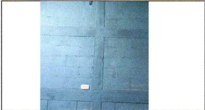
Sustitución de cableado eléctrico
