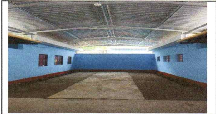
Sustitución de lamina troquelada calibre 26
