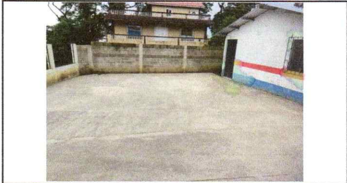
Sustitución de piso de concreto
