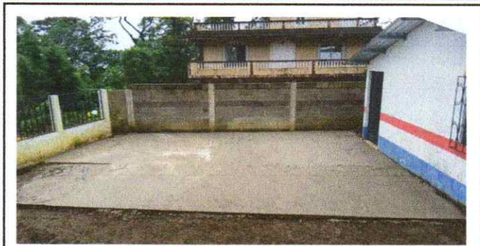
Sustitución de piso de concreto
