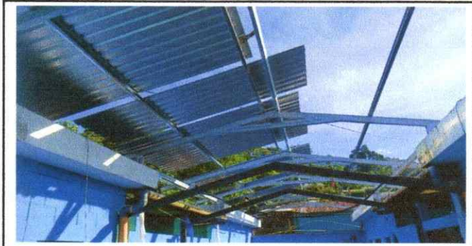
Sustitución de lamina troquelada calibre 26
