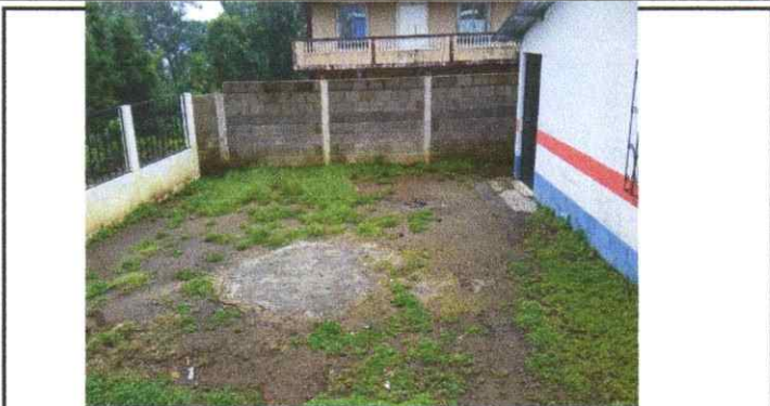
Sustitución de piso de concreto
