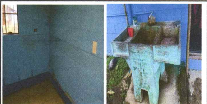
Instalación de lavaplatos y Sustitucion de pila de concreto
