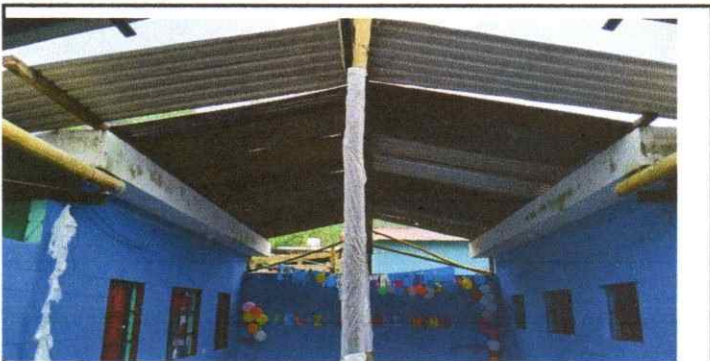
Sustitución de lamina troquelada calibre 26
