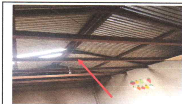
Mantenimiento de Cocina.
