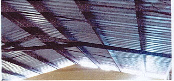
SUMINISTRO Y MANTENIMIENTO DE ESTRUCTURA DE SOPORTE
