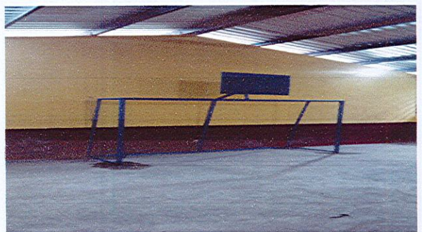
SUMINISTRO Y INSTALCION DE RELECTORES LED Y PORTERIAS DE METAL
