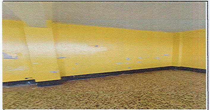
10. Aplicación Pintura interior látex
