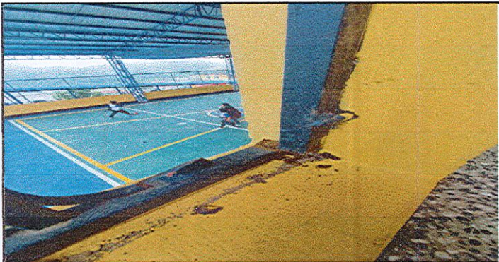
9. Mantenimiento a barandas de metal en pasillos
