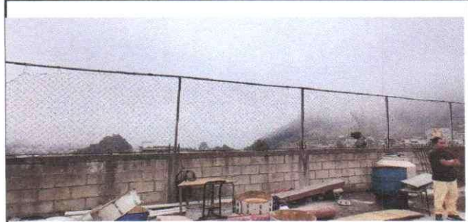
Sustitución de estructura de madera de techo area recreativa por metalico
