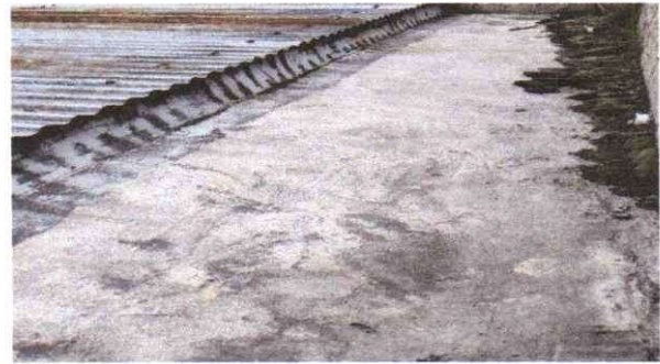
Suministro y aplicación de impermeabilizante acrilico
