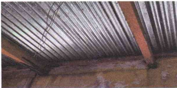
Sustitución de estructura de madera de techo área recreativa por metalico
