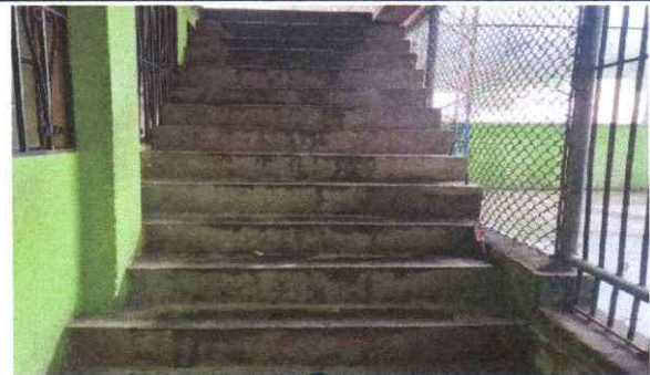
Sustitución de piso ceramico en modulo de gradas
