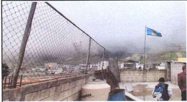
Sustitución de estructura de madera de techo área recreativa por metalico
