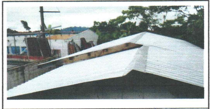
Foto 6: Describir la actividad de la fotografía PRIMERA PARTE ENTECHADO
