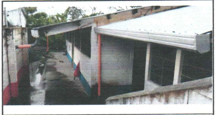
Foto 2: Describir la actividad de la fotografía colocación de canales de agua
