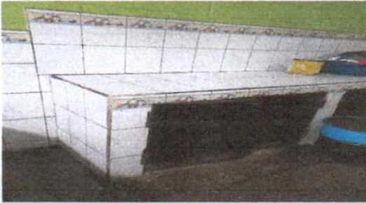
Reparación y consrucción de estufa en cocina con ladrillo y chimenea
