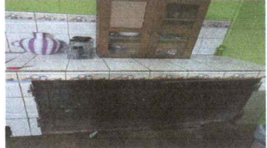
Reparación y fabricación de cocina con lavatrastos
