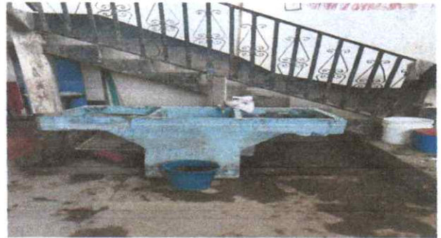
Sustitución y fabricación de tanque de agua con lavaderos
