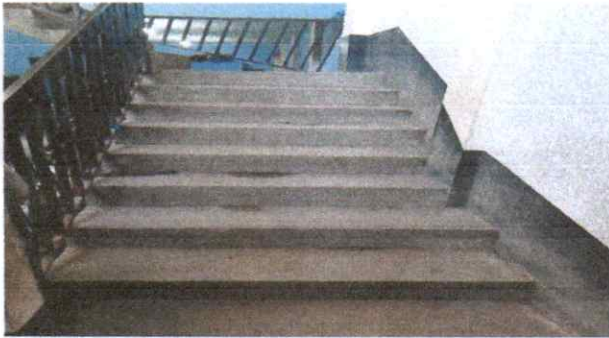
sustitución de piso de concreto por piso antideslizante en gradas
