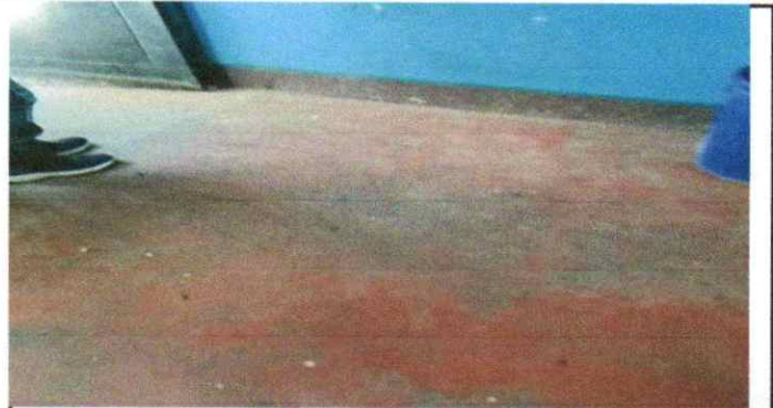
Cambio de piso de un aula.
