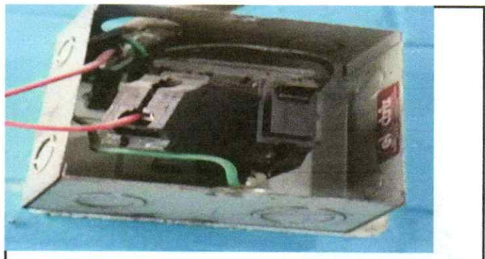
Foto 4: Describir la actividad de la fotografía Cambio de plafonera y algunos alambres de la energia electrica
