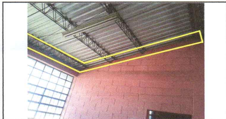
Reparación de cocina
