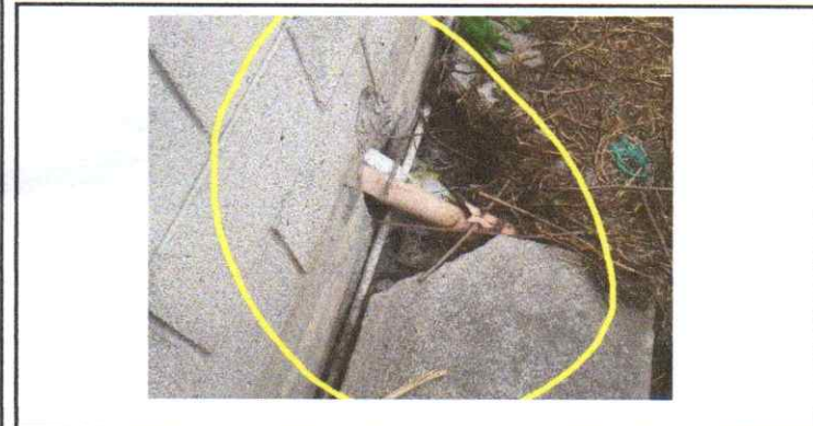
Mantenimiento de caja de registro.
