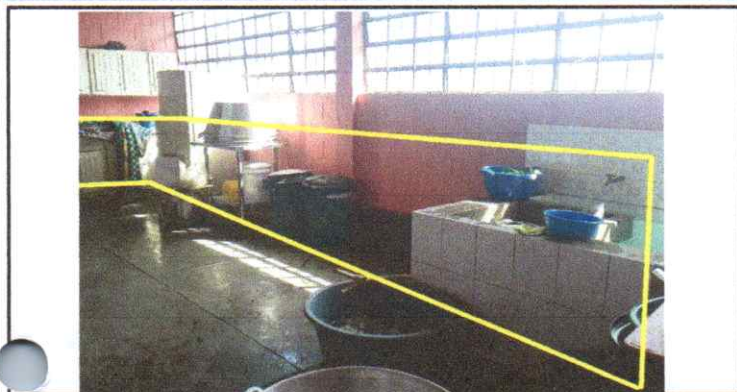
Reparación de estufa en cocina con ladrillo y chimenea, Reparación de mesa de trabajo en cocina, Sustitución de azulejo en cocina, Reparación de cocina con lavatrastos
