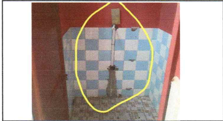
Sustitución de mingitorio
