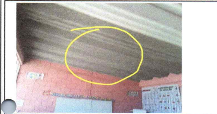
Sustitución de estructura de soporte por metal en 7 aulas.
