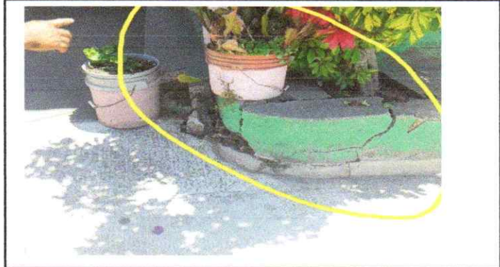
Sustitución de piso con adoquin, tráfico liviano decorativo
