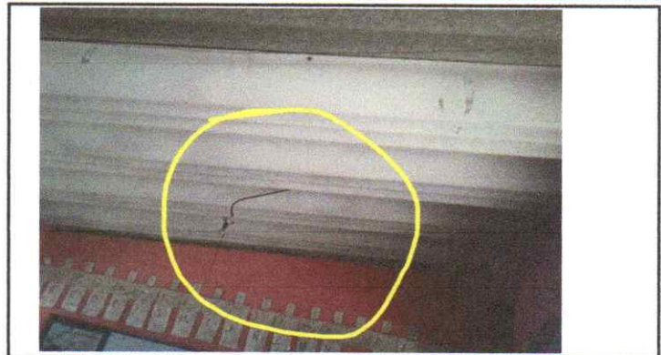
Sustitución de estructura de soporte por metal en 7 aulas.
