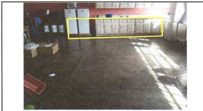
Reparación de mesa de trabajo en cocina, Reparación de cableado eléctrico CALIBRE 12 AWB, Sustitución de tomacorrientes dobles.
