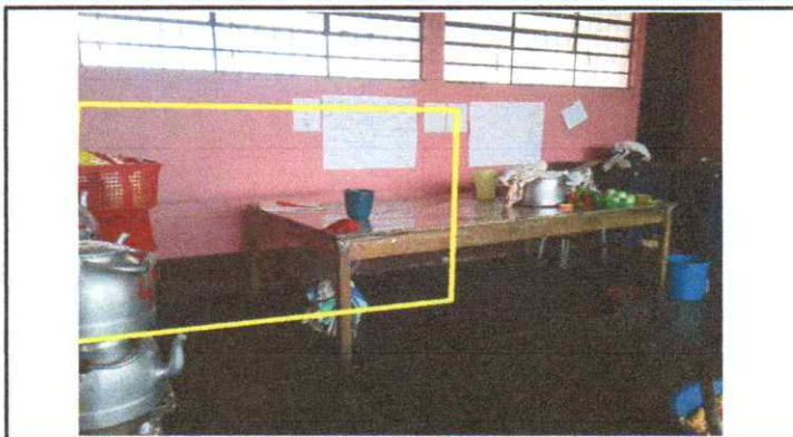
Sustitución de estructura de metal de ventana.
