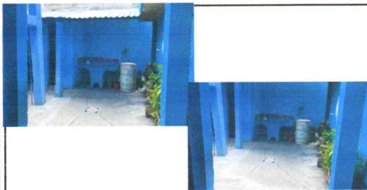
Foto 5: Sustitución de torta de concreto
