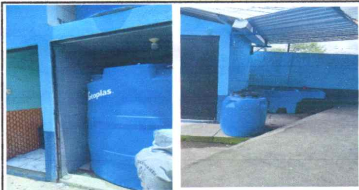
Suministro e instalación de cisterna y equipo de bombeo para agua tipo centrífuga
