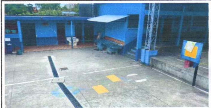
Foto 4: Mantenimiento de drenaje
