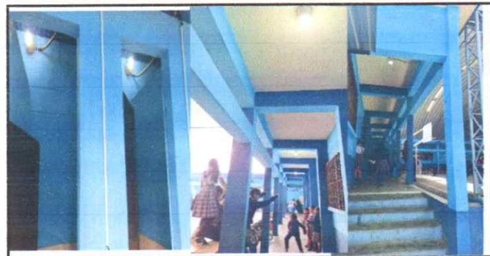
Foto 6: Mantenimiento general del sistema eléctrico
