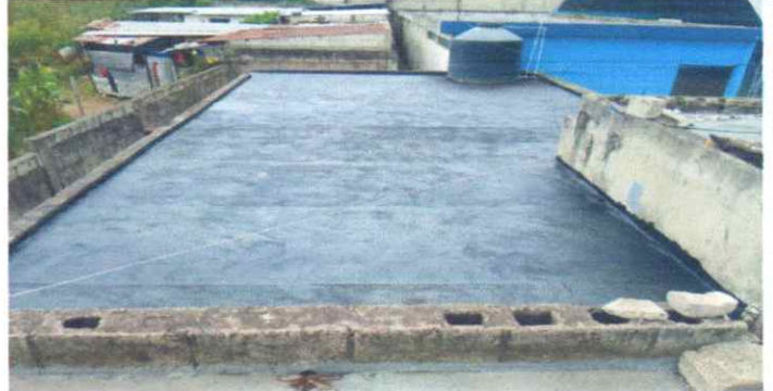
Foto 2: Suministro y aplicación de manto asfáltico modulo de servicios sanitarios
