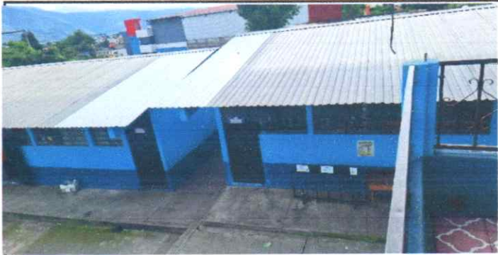
Foto1: Mantenimiento de lámina troquelada modulo de aulas
