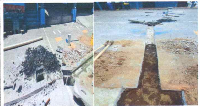
Foto 4: Mantenimiento de drenaje
