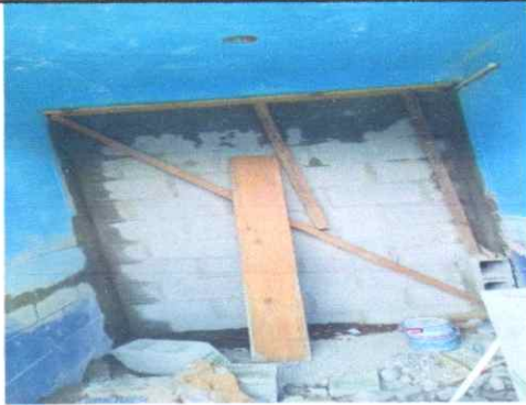
Foto 3: Suministro e instalación de cisterna y equipo de bombeo para agua tipo centrífuga
