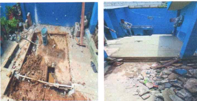
Foto 5: Sustitución de torta de concreto
