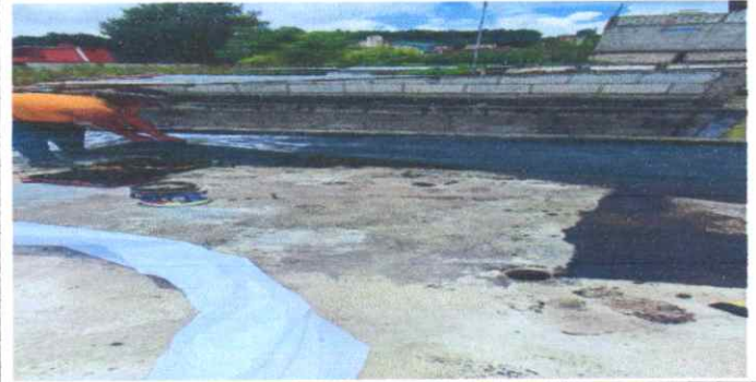
Foto 2: Suministro y aplicación de manto asfáltico
