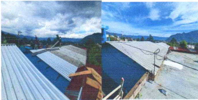
Foto1: Mantenimiento de lámina troquelada módulo de aulas
