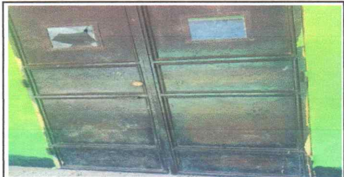
Sustitución de puertas
