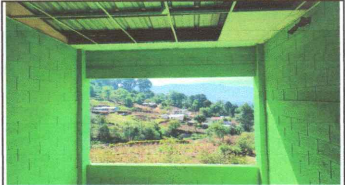
Sustitución de balcones
