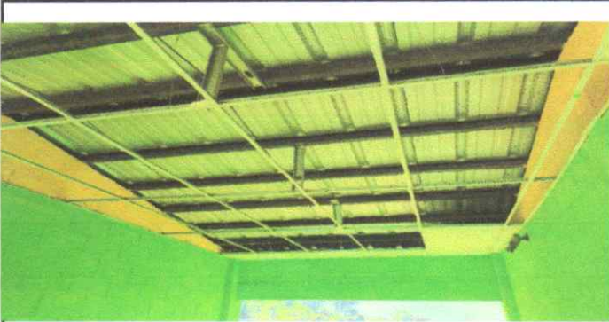
Sustitución de cielo falso vinil laminado
