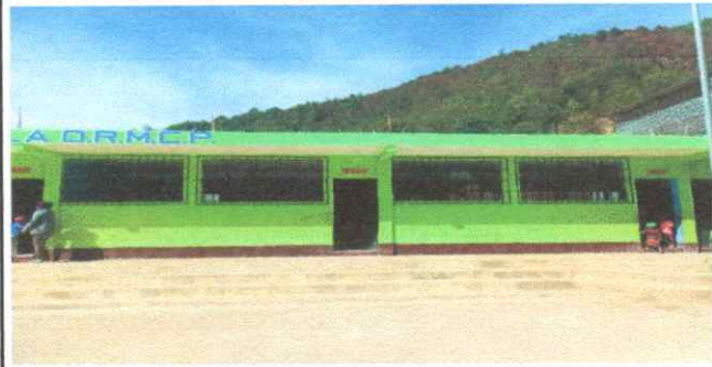
Suministro e instalación de gradas
