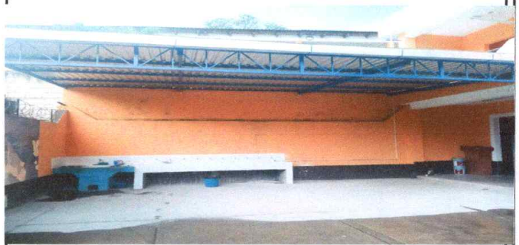
Foto 2: Instalacion de lamina troquelada.
