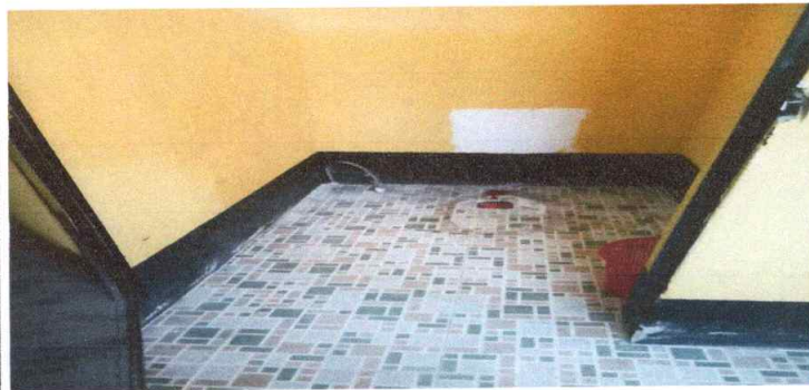
Foto 5: Sustitucion de Servicios Sanitarios.
