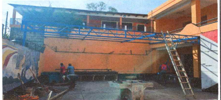
Foto 4: Instalacion de estructura portante.
