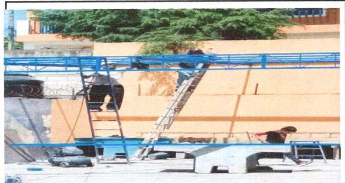
Foto 2: Instalacion de laminas troqueladas
