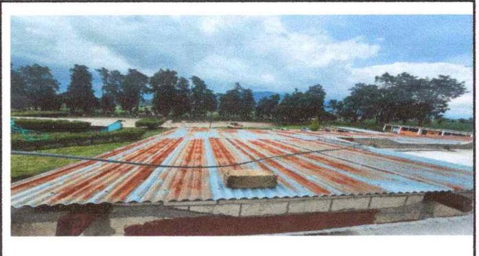
Sustitucion de estructura portante
