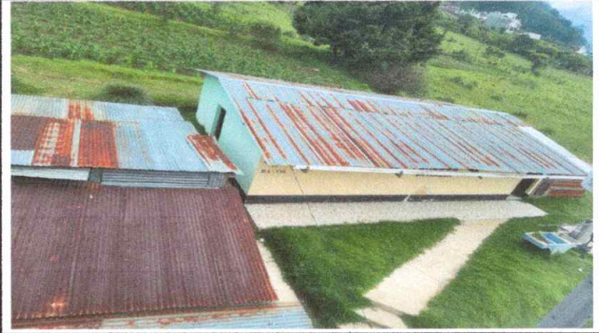
Sustitución de lámina, por lámina troquelada Calibre 26 para modulo de servicios sanitarios
