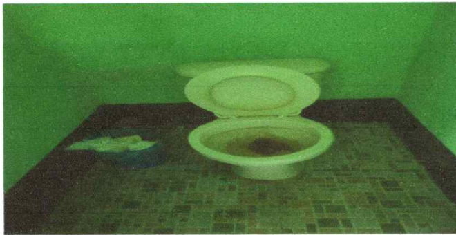
Sustitución de inodoros
