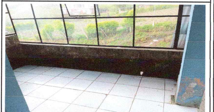
Foto 4: Terminación de piso cerámico y ventanales
