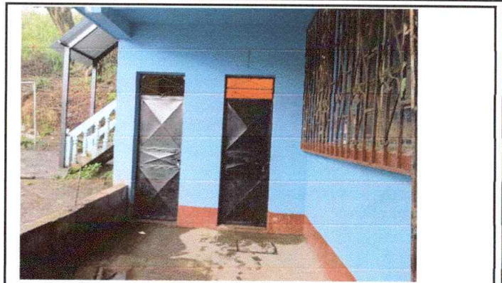
Foto 2: Suministro y mantenimiento de puertas de metal con pintura anticorrosiva
