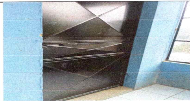
Foto 5: Suministro y mantenimiento de puertas de metal con pintura anticorrosiva
