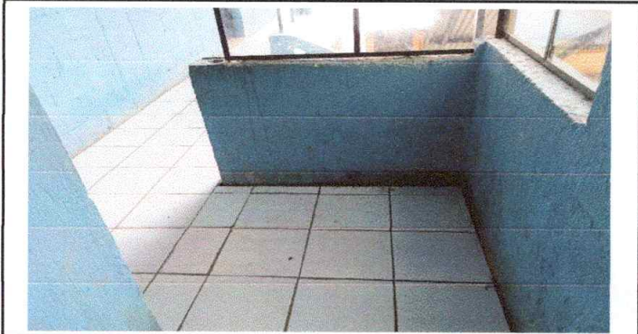
Foto 3: Terminación de piso cerámico y ventanales
