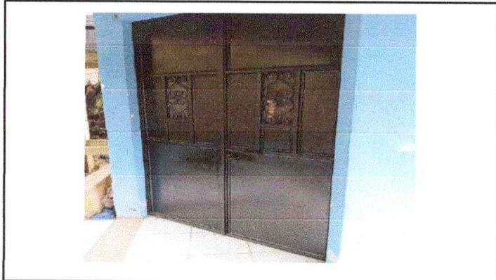
Foto1: .Suministro y mantenimiento de puertas de metal con pintura anticorrosiva
