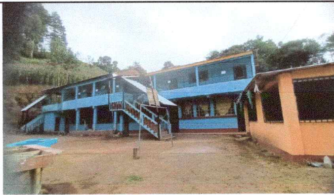
Foto1: .Finalización de techo en las gradas lado 1
