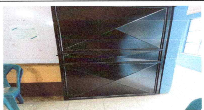
Foto 6: Suministro y mantenimiento de puertas de metal con pintura anticorrosiva
