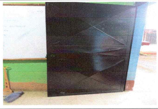
Foto 4: Suministro y mantenimiento de puertas de metal con pintura anticorrosiva
