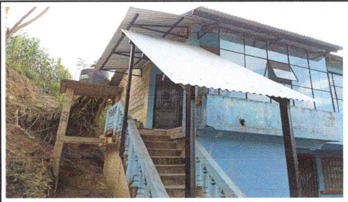
Foto 2: Finalización de techo en las gradas lado 2
