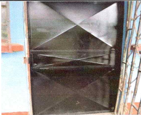
Foto 3: Suministro y mantenimiento de puertas de metal con pintura anticorrosiva
