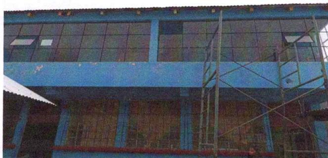
Foto 5: Dcolocación de vidrieras del primer lado
