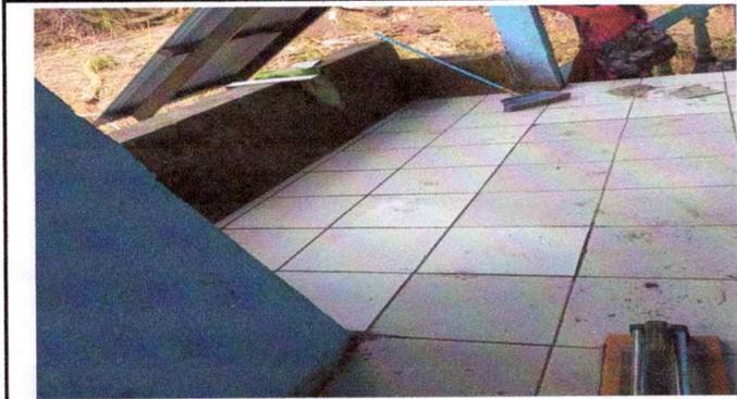
Foto1: Colocación de piso cerámico lado dos
