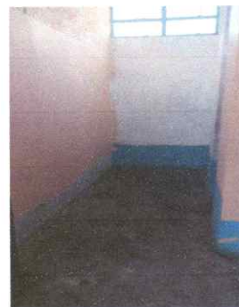
Foto 4: Suministro y aplicación de pintura Sherwin Williams
