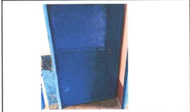
Foto 1: Reparación de dos puertas de metal
