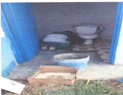
Foto 3: SUMINISTRO E INSTALACIÓN DE PISO CERAMICO
