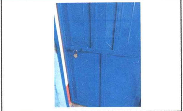
Foto 2: Suministro e instalación de puerta de metal
