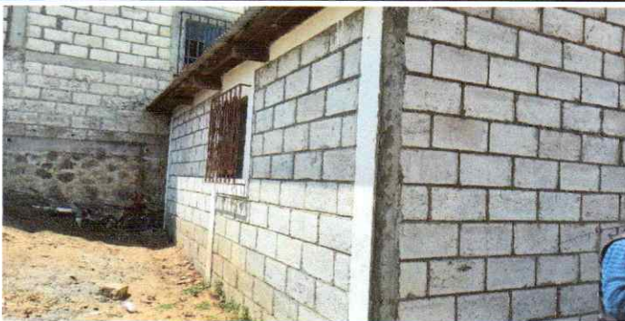
Foto 5: ESTADO DE LA COCINA EXTERIOR
