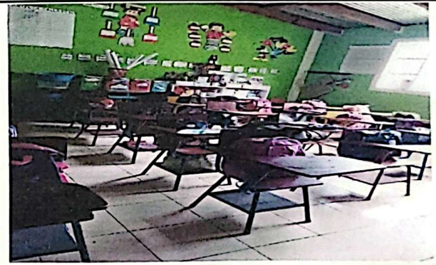
Foto 4: Suministro e instalacion de pisos ceramicos aula 4
