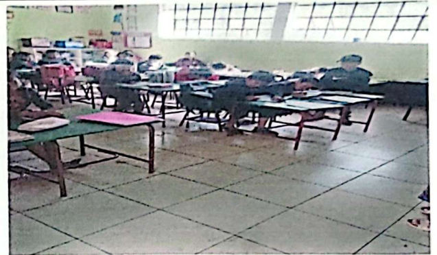
Foto 2: Suministro e instalacion de pisos ceramicos aula 2
