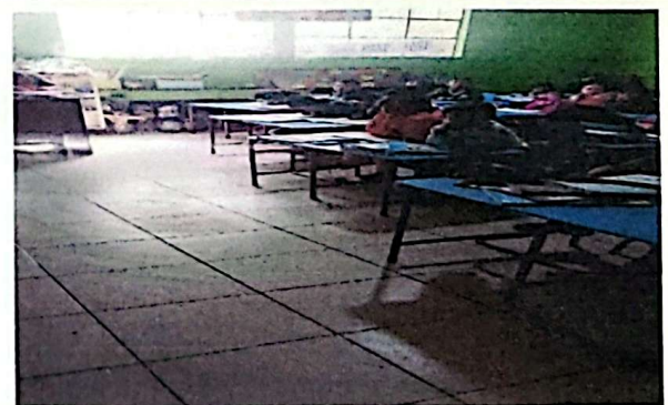
Foto 6: Suministro e instalacion de pisos ceramicos aula 6
