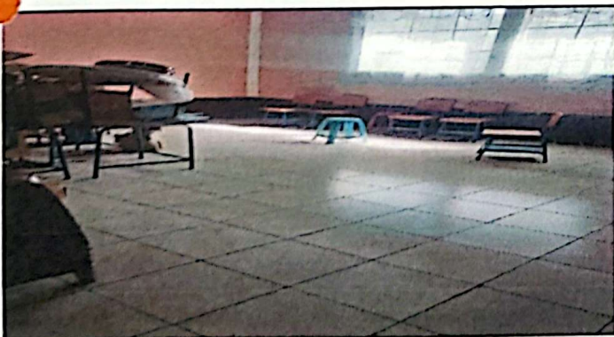
Foto 5: Suministro e instalacion de pisos ceramicos aula 5
