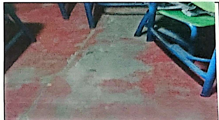
Foto 6: Suministro e instalacion de pisos ceramicos aula 6
