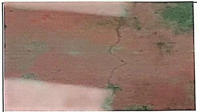
Foto 4: Suministro e instalacion de pisos ceramicos aula 4
