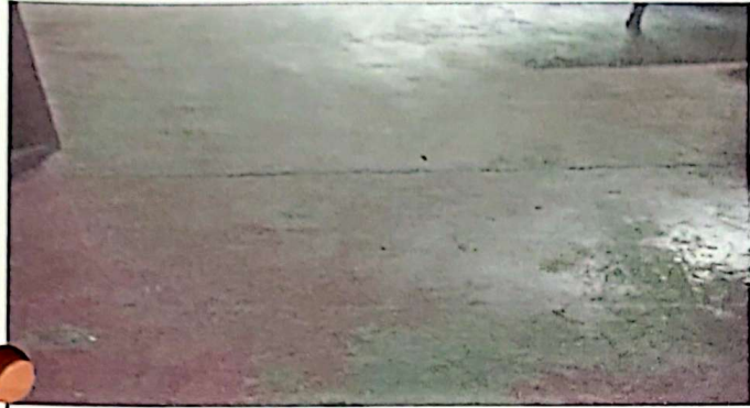
Foto 1: Suministro e instalacion de pisos ceramicos aula 1
