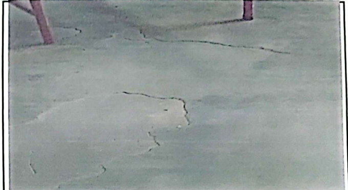
Foto 2: Suministro e instalacion de pisos ceramicos aula 2
