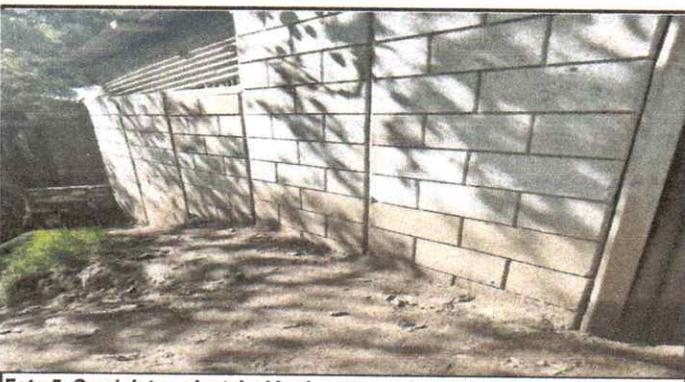
Foto 5: Suministro e instalación de muro perimetral prefabricado de placas y columnas de concreto reforzado.
