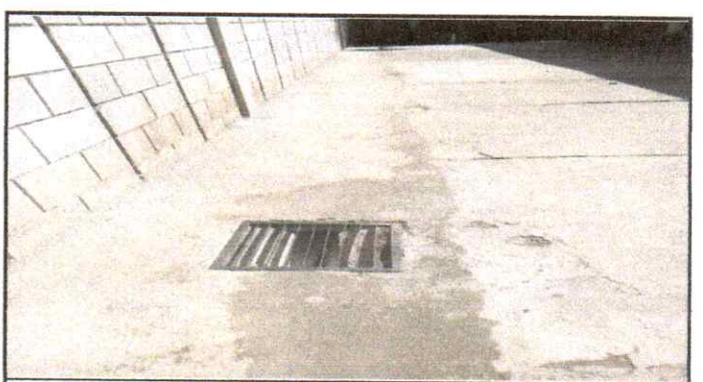
Foto 6: Sustitución e instalación de tubería pvc línea principal aguas pluviales y reposaderas para patio.
