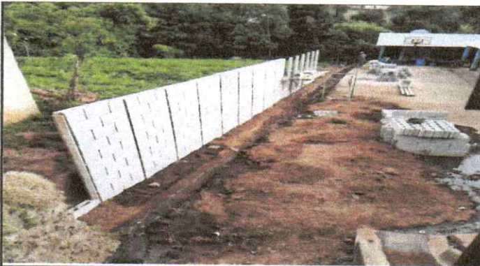
Foto 3: Suministro e instalación de muro perimetral prefabricado de placas y columnas de concreto reforzado.
