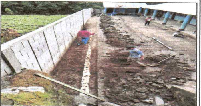
Foto 6: Sustitución e instalación de tubería pvc línea principal aguas pluviales y reposaderas para patio.
