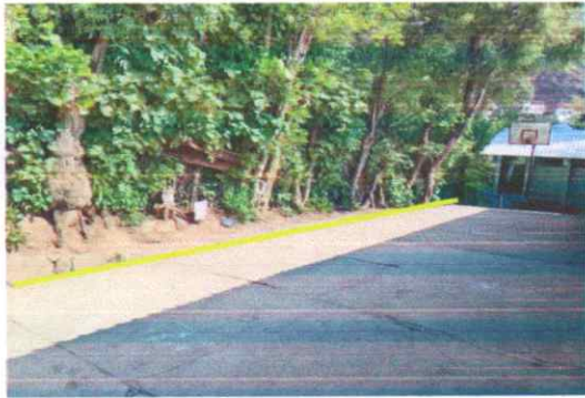
Suministro e instalación de muro perimetral prefabricado de placas y columnas de concreto reforzado de 2.50m de alto
