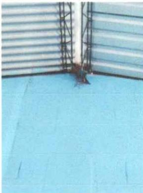
Suministro e instalación de costaneras galvanizadas de 2x4 y tubo rectangular de 1x2 para darle resistencia a las láminas y sellar con espuma expansible para evitar ingreso de aves
