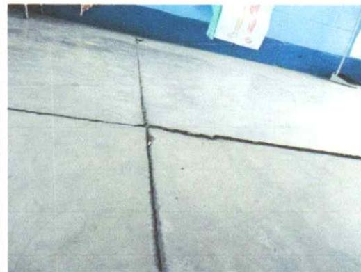
Suministro e instalación de 58 metros de torta de concreto con un grosor de 6 centímetros
