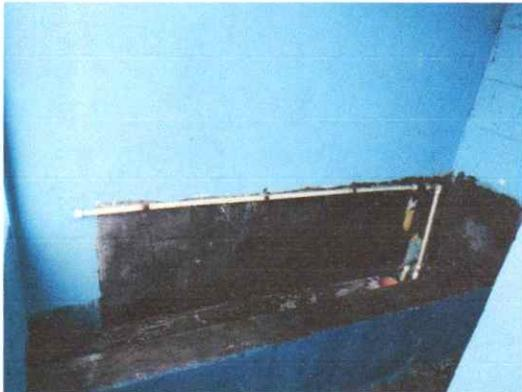
Suministro y mantenimiento de 3 orinaderos para niños de concreto, con azulejo por dentro y entorno con drenaje conectado a pozo de absorción
