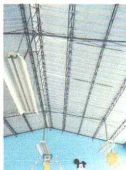
Sustitución de estructura de madera y cubierta de lámina por suministro e instalación de costaneras de 6x2 chapa 16 y tubis rectangulares de 2x4 y reinstalación de lámina
