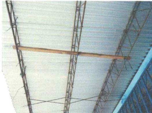
Suministro y mantenimiento a estructura de techo, se desmontará la totalidad de la lámina, para instalar plaquetas de estructura tipo yoyo, para sujetar y reforzar con tornillos poolser
