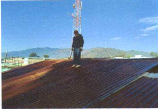
Sustitucion de Lámina troquelada Cal. 26
