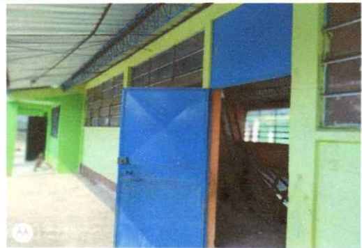
Suministro e instalación de balcones
