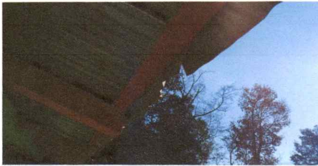
Sustitucion de estructura portante de madera a metal
