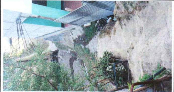
Sustitución de muro de Perimetral, Pintura
