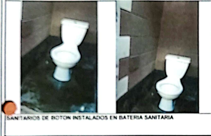
SANITARIOS DE BOTON INSTALADOS EN BATERIA SANITARIA
