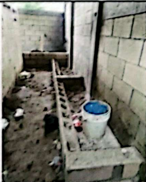
PROCESO DE AVANCE DE MINGITORIOS RUSTICOS
