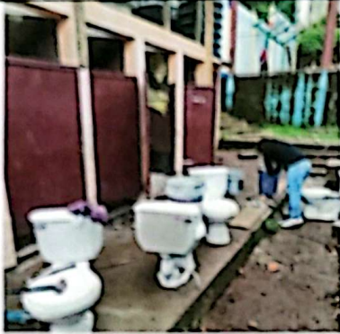
DESINSTALACIÓN DE BATERIA DE CINCO SANITARIOS DE PALANCA
