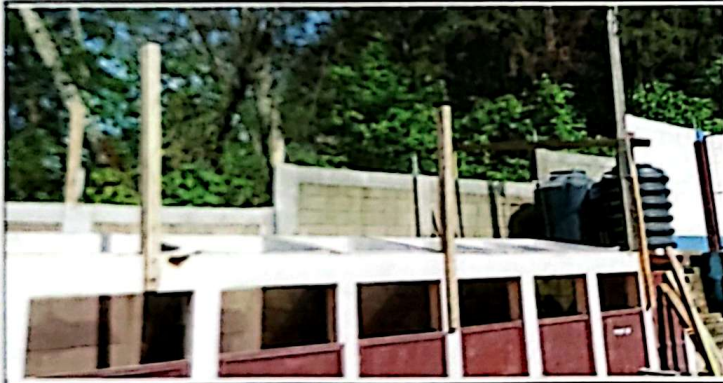
PROCESO DE ENTECHADO DE BATERIA SANITARIA INCLUYENDO MINGITORIOS RUSTICOS ATRÁS
