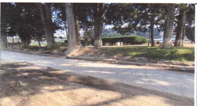
Suministro e instalación de muro prefabricado de concreto reforzado
