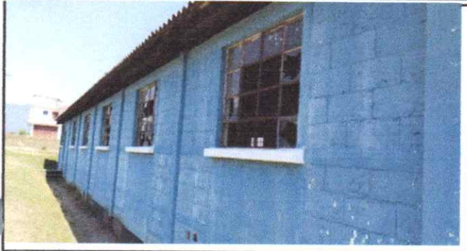
Suministro e instalación de balcones, Suministro de instalación de vidrio transparente
