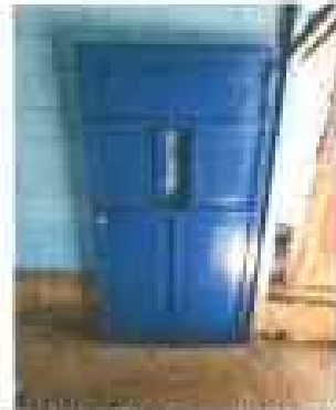
Reforzamiento de puerta de metal en un 80% concluido
