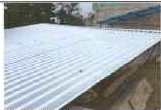
Reforzamiento de techo en gulo 1
