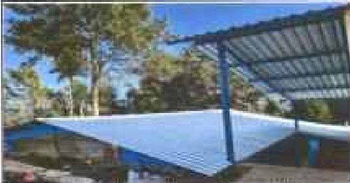
Reforzamiento de estructura de metal como techo para evitar lluvias
