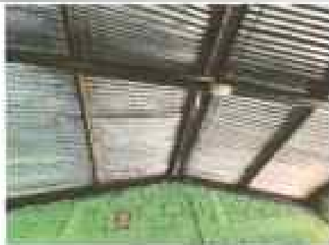
Foto 3: En el interior de las aulas se observa que la estructura presenta un trabajo reciente realizado para su ventilación.
