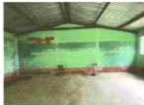
Foto 6: Aula 2, con humedad en las muros y filtración dentro del aula, por lo que se requiere reemplazar la cubierta de tierra.
