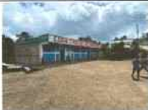
Foto 1: Fachada principal de establecimiento educativo beneficiado con el programa de mantenimiento.
