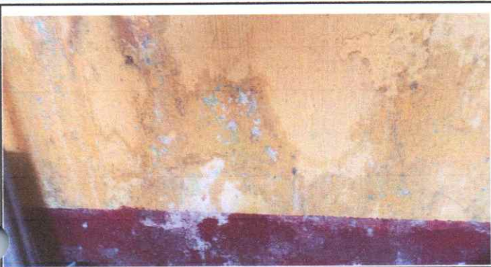
Reparación de muros con repello e impermeabilizacion, Sustitucion de lamina
