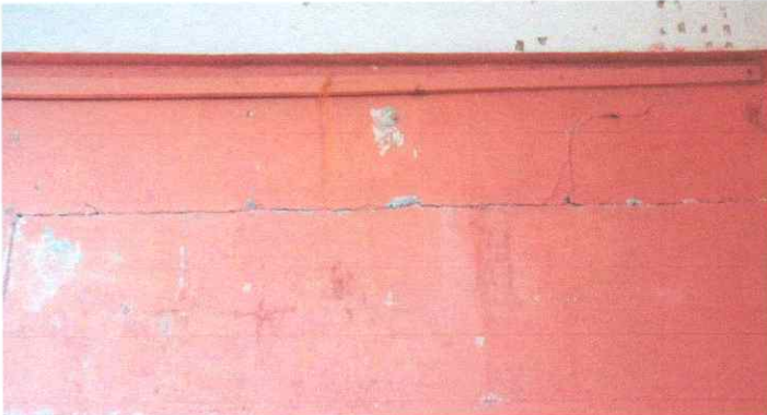
Sustitucion de muro perimetral de aulas h=2.50m
