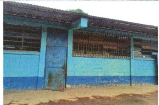
Suministro y aplicacion de pintura en muros interiores y exteriores
