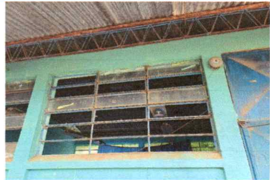
Sustitucion de balcones de metal
