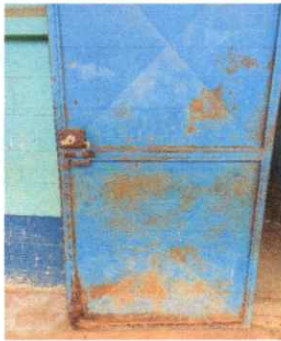
Sustitucion de puerta de metal
