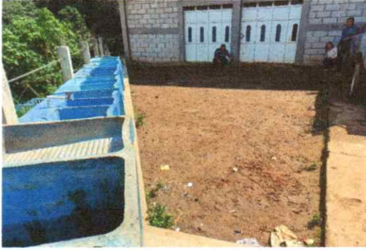
Sustitucion de torta de concreto en patio
