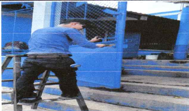
MANTENIMIENTO A PORTON DE METAL .
