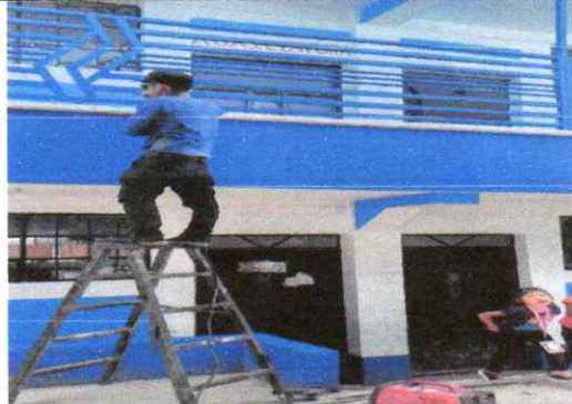
INSTALACION DE BARABDAS A PASILLO. (POR INSTRUCCION DE LOS BOMBEROS VOLUNTARIOS)
