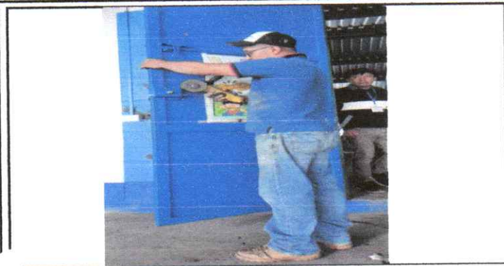
SUSTITUCION DE CHAPAS
