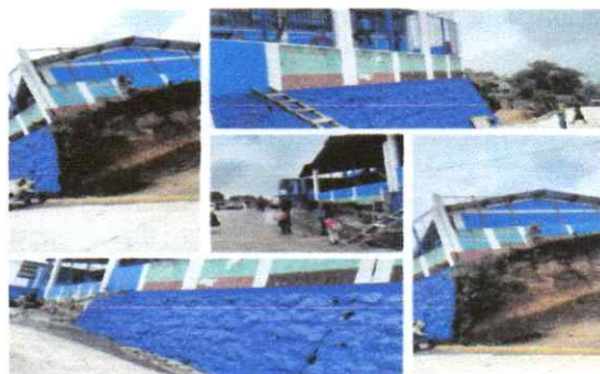
Aplicación de pintura exterior Latex para muros.
