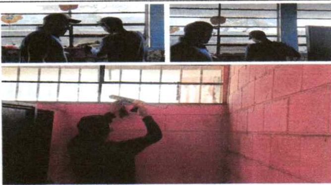
SUSTITUCION DE VIDRIOS EN AULAS, SANITARIOS PARA NIÑOS Y NIÑAS
