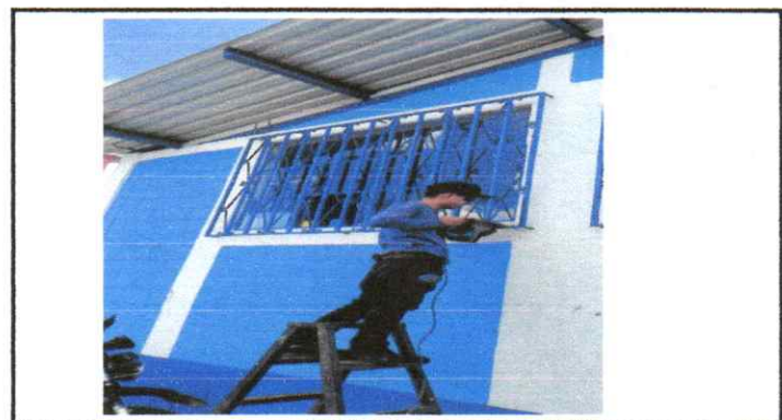
INSTALACION DE BALCONES
