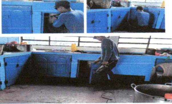
SUSTITUCION DE CINCO PUERTAS METALICAS DE MESA PARA TRABAJO DE COCINA
