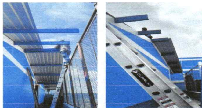
SUSTITUCION DE ESTRUCTURA DE SOPORTE CON INSTALACION DE LAMINA
