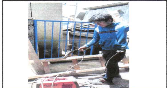
INSTALACION DE PUERTA PARA SEGURIDAD DE TANQUE DE AGUA Y SISTEMA DE BOMBEO
