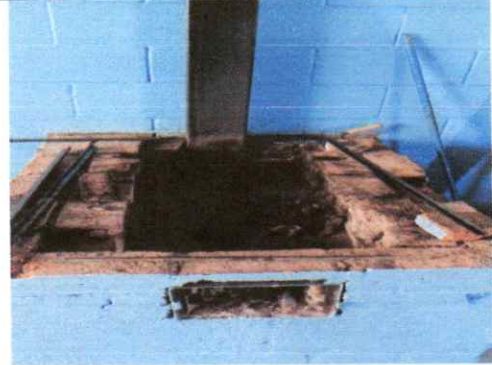
REPARACION DE ESTUFA CON CHIMENEA METALICA EN COCINA
