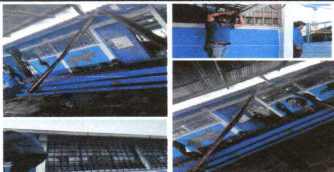
SUSTITUCION DE CANAL PVC.
