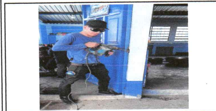
INSTALACION DE UNA PUERTA NUEVA METALICA ENCHAPADA
