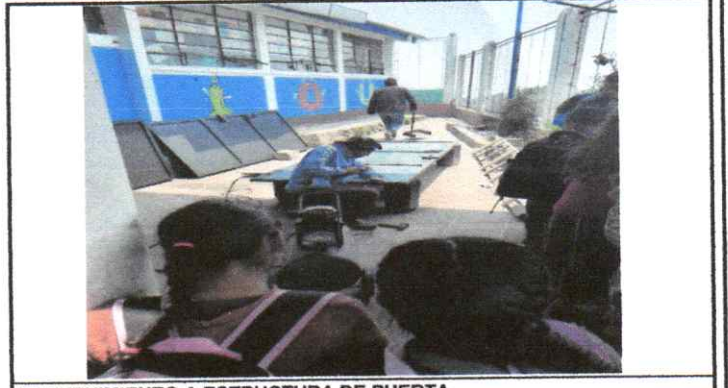
MANTENIMIENTO A ESTRUCTURA DE PUERTA
