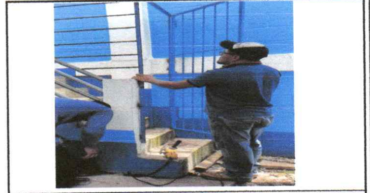
INSTALACION DE UNA PUERTA NUEVA PARA GRADAS
