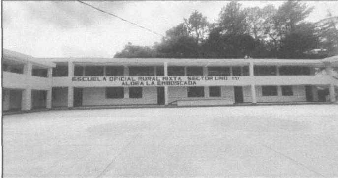
Aplicación de pintura en muros
