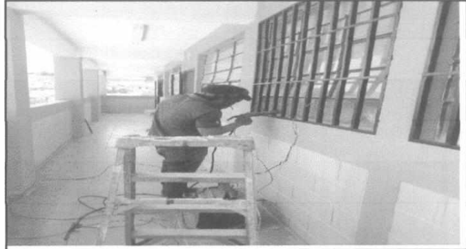
Sustitucion de balcones
