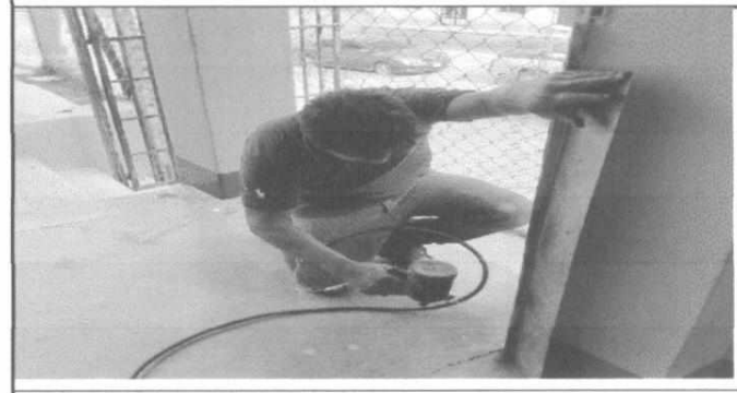
Mantennimiento de puertas
