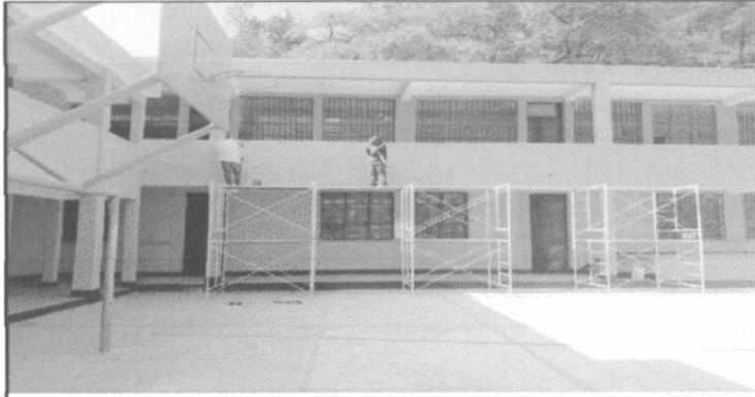
Aplicación de pintura en muros
