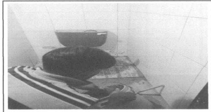
Sustitución de piso y azulejo
