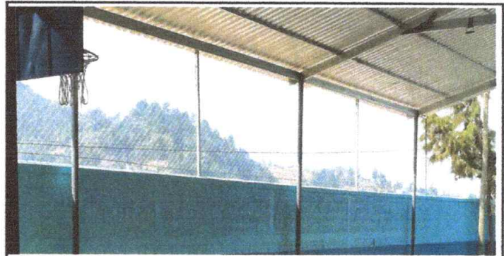
Foto 15: VISTA DE MALLA GALVANIZADA 100% FINALIZADA.
