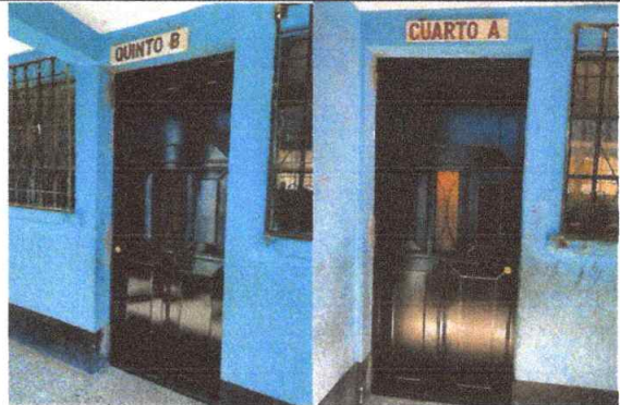
Foto 2: VISTA DE INSTALACIÓN DE PUERTAS FINALIZADO
