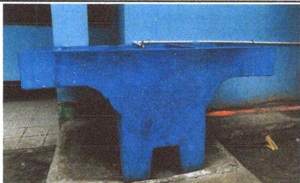
Foto 11: VISTA DE SUSTITUCIÓN DE PILA FINALIZADO.
