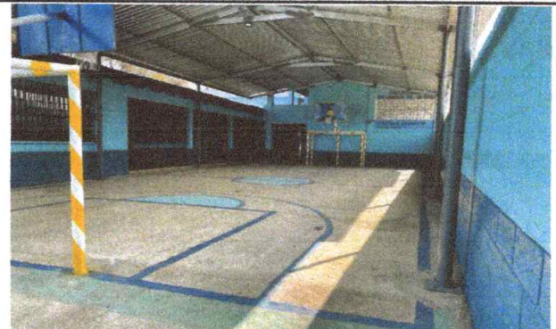
Foto 14: VISTA DE APLICACIÓN DE PINTURA EXTERIOR FINALIZADO
