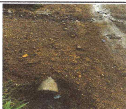
Foto 10: VISTA DE SUSTITUCIÓN DE TUBERIAS DE CONCRETO FINALIZADO
