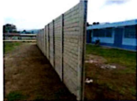
Suministro e instalacion de Columnas Tipo H Mediana
