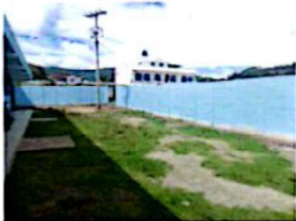
Suministro e instalacion de portón metálico
