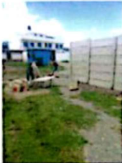
Mano de obra para instalacion de muro perimetral prefabricado 65m2
