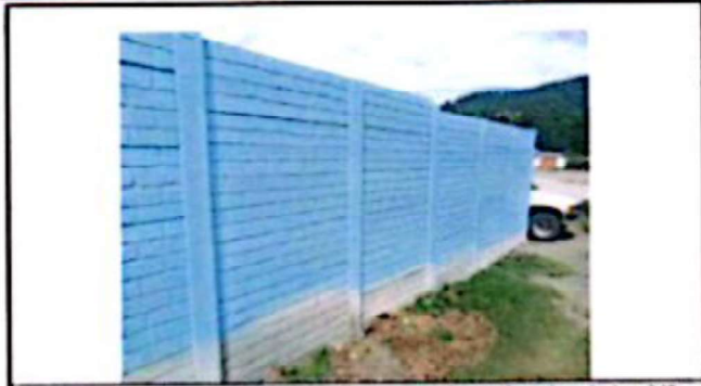
Suministro y aplicación de Pintura de muro perimetral, ambos lados 140 m2
