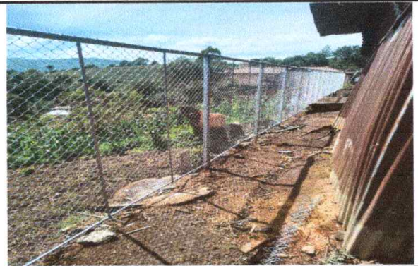
Foto 4: Sustitución de malla de muro perimetral
