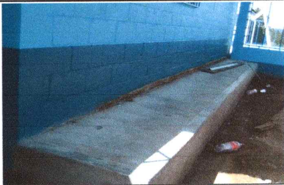
Foto 5: Muro perimetral de block
