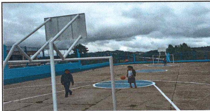
Foto 3: Pintura de muros perimetrales y cancha polideportiva
