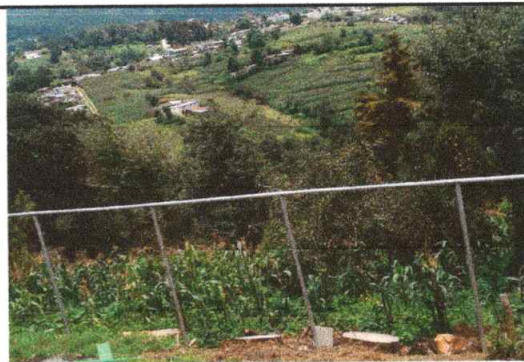
Foto 6: Sustitución de maya y tubos galvanizados
