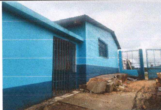
Foto 2: Pintura en aulas
