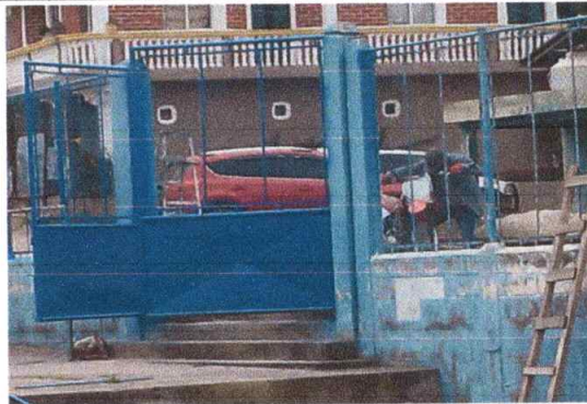
Foto 4: Pintura en muros
