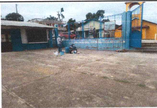
Foto 5: Pintura en cocina y muros
