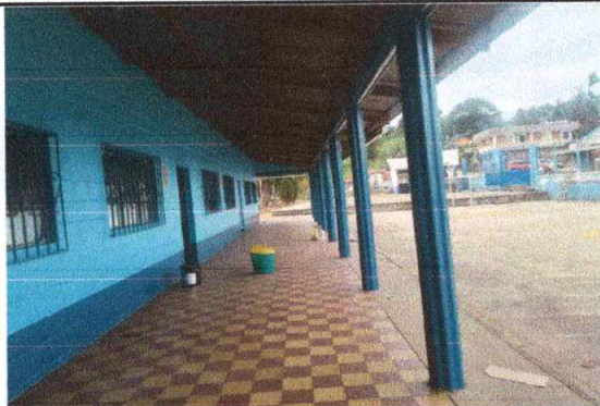
Foto 3: Pintura en aulas exteriores
