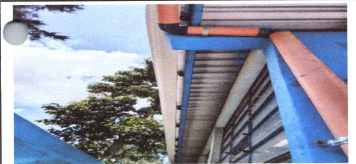
Suministro e instalación de canales de PVC y tubos de 3 pulgadas para caídas
