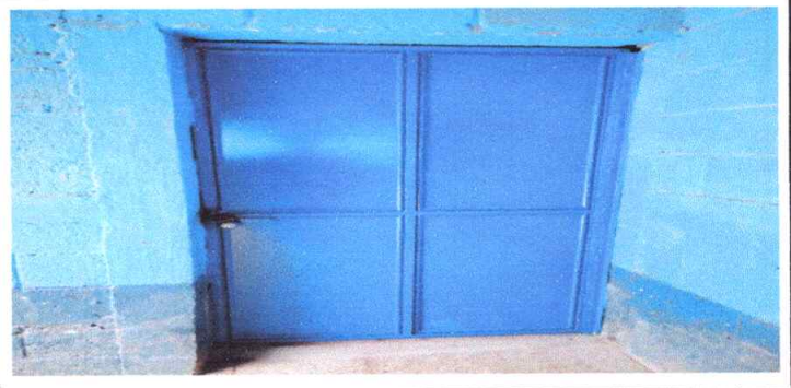
Mantenimiento y pintura de puertas
