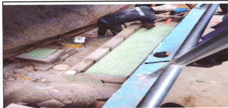
Sustitución de multichorros
