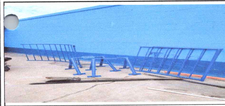
Suministro e instalacion de baranda de metal
