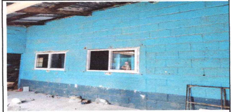
Sustitución de ventanas a PVC
