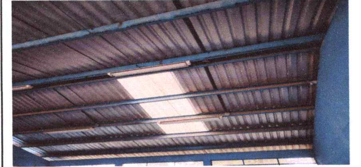
Sustitución de láminas a láminas transparentes
