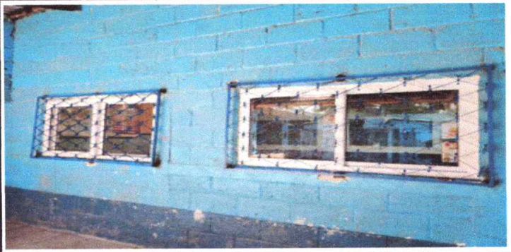
Mantenimiento de balcones
