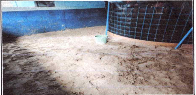
Sustitución de torta de piso alisado
