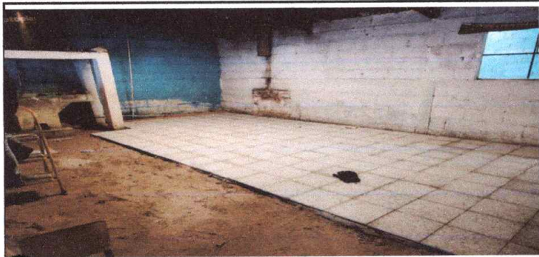
Sustitución de piso a granito de marmol
