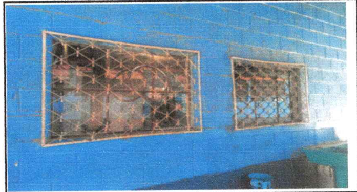
Mantenimiento de balcones
