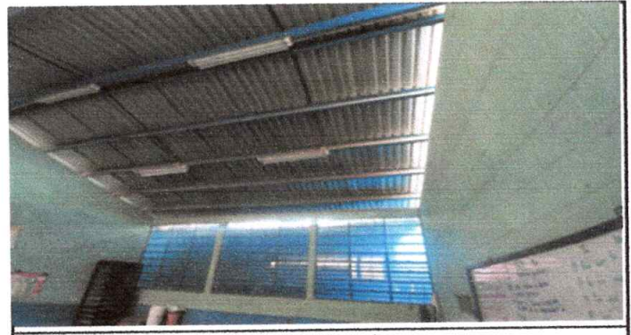
Sustitución de laminas a láminas transparentes
