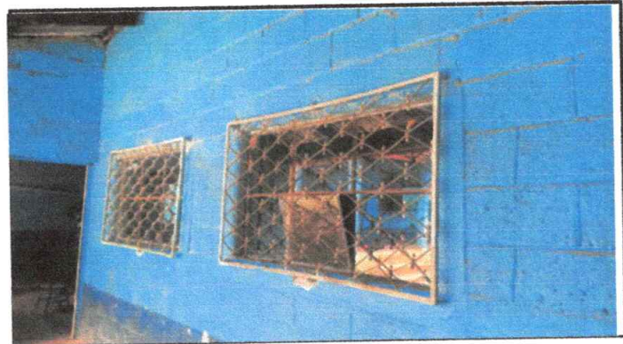
Sustitución de ventanas a PVC
