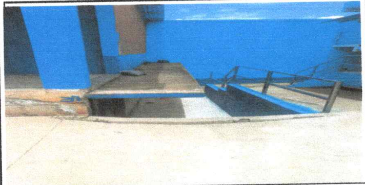
Suministro e instalacion de baranda de metal
