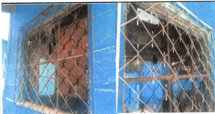
Sustitución de vidrios
