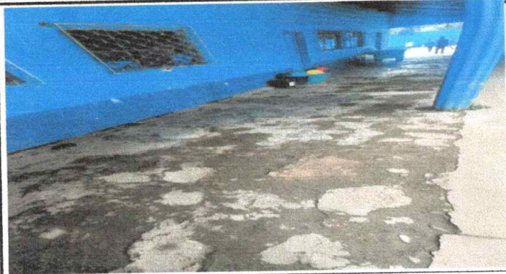
Sustitución de piso a granito de marmol
