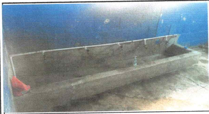
Sustitución de multichorros
