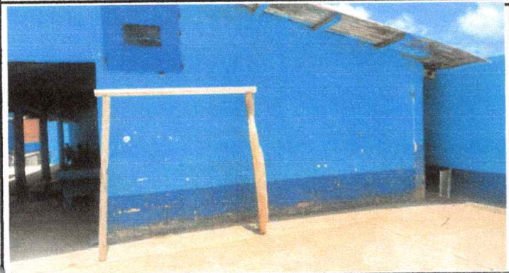
Sustitución de porterías y tableros
