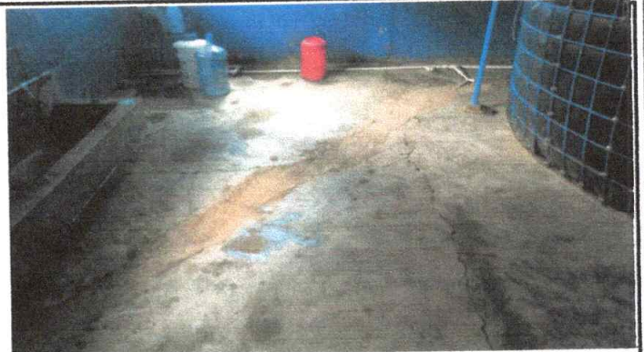
Sustitución de torta de piso allsado
